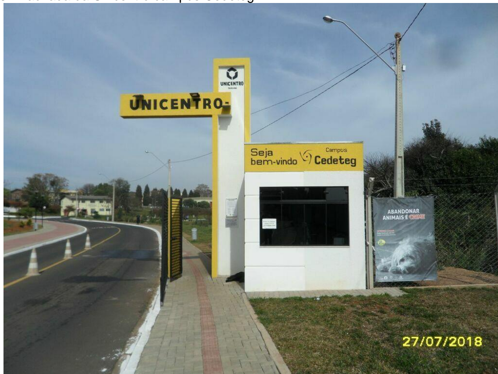
Figura 13 - Fachada da Unicentro campus Cedeteg.
