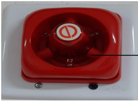
SIRENE DE ALARME CONTRA INCÊNDIO ELETRÔNICA COM LED
