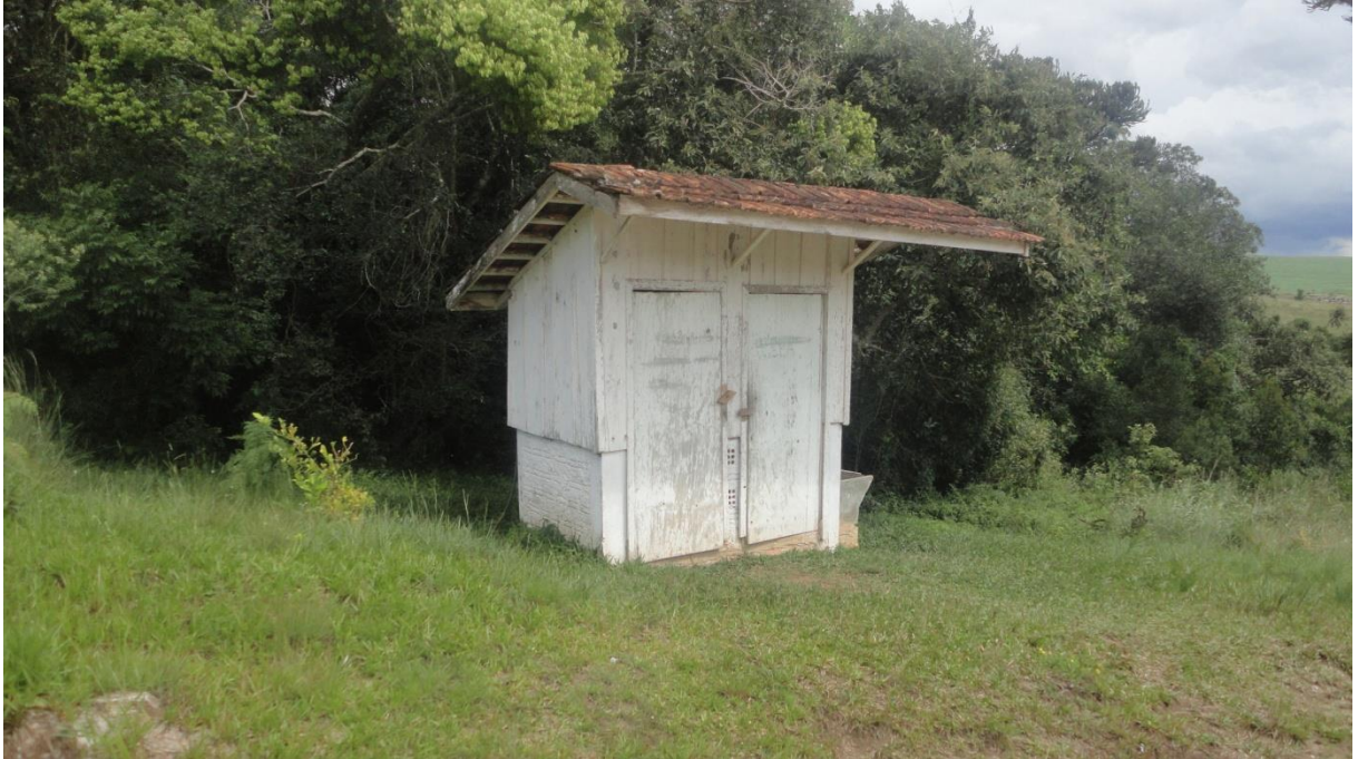
Foto 13 – estado de conservação dos banheiros na área da Cachoeira da Mariquinha. Fonte: acervo de fotos do autor
