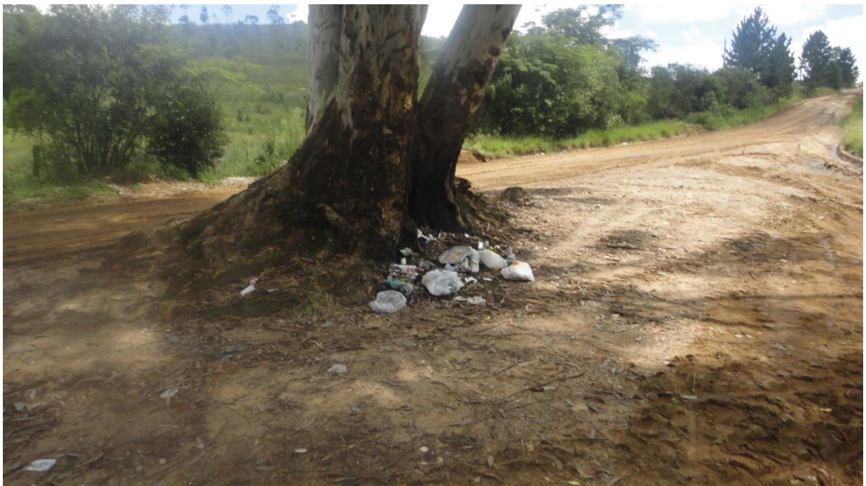
Foto 3 – falta de infraestrutura na Ponte do Rio São Jorge
