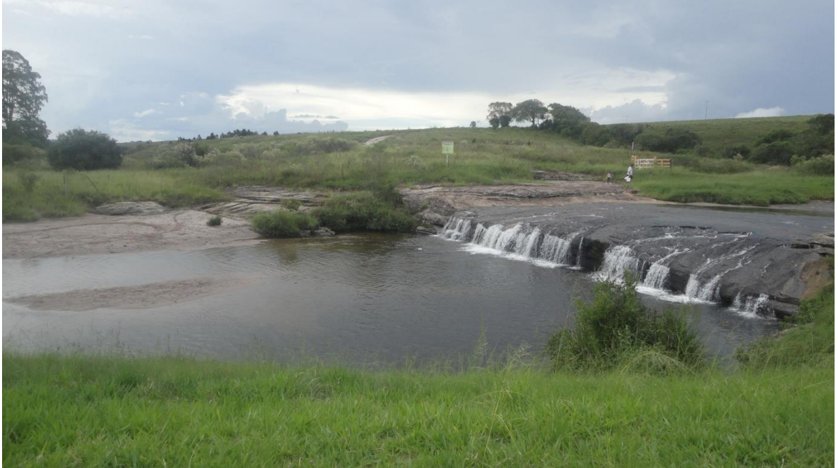
Foto 9 – Queda d'água Capão da Onça Fonte: acervo de fotos do autor
