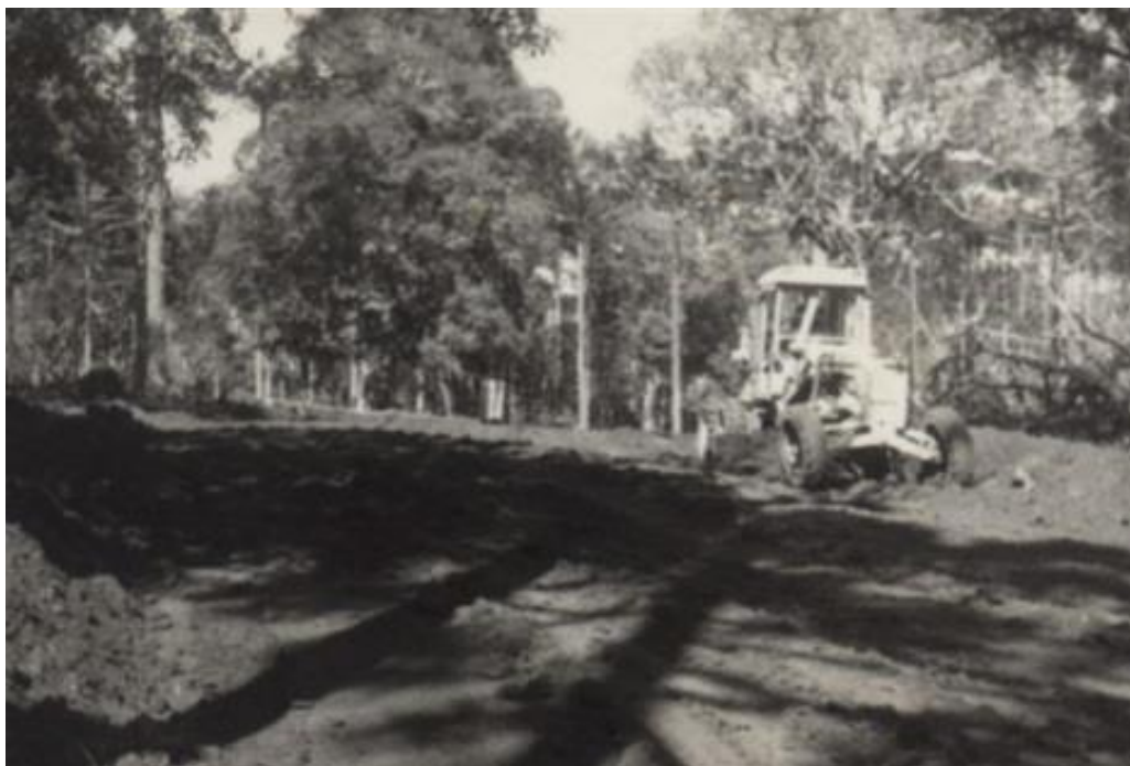
Figura 4 – Obras de construção do Autódromo. Fonte: São Bento Motor Clube
