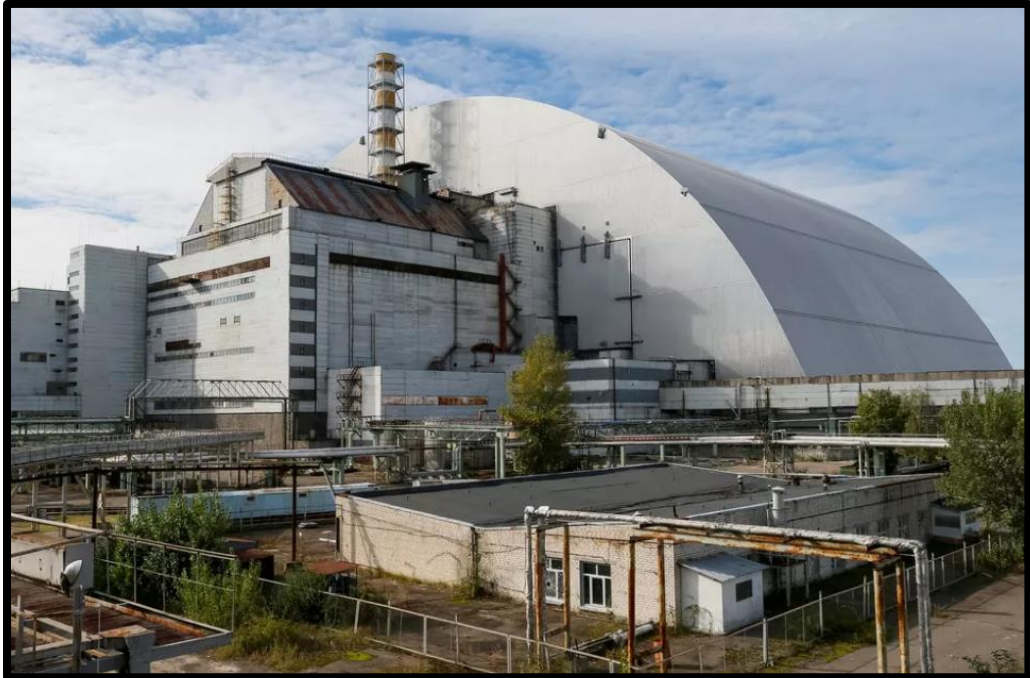
Figura 5 - Reator 4 na atualidade, coberto pelo chamado “Sarcófago de Chernobyl”, construído para conter a radiação
