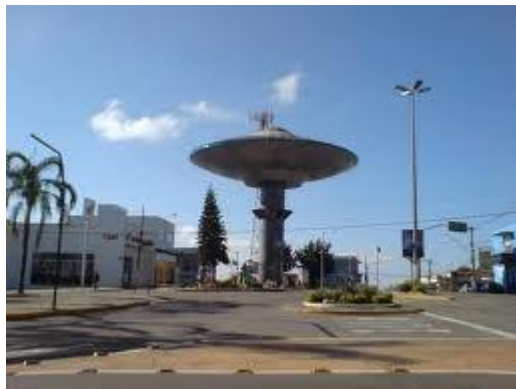
FIGURA 13 – Caixa D’água em Varginha
