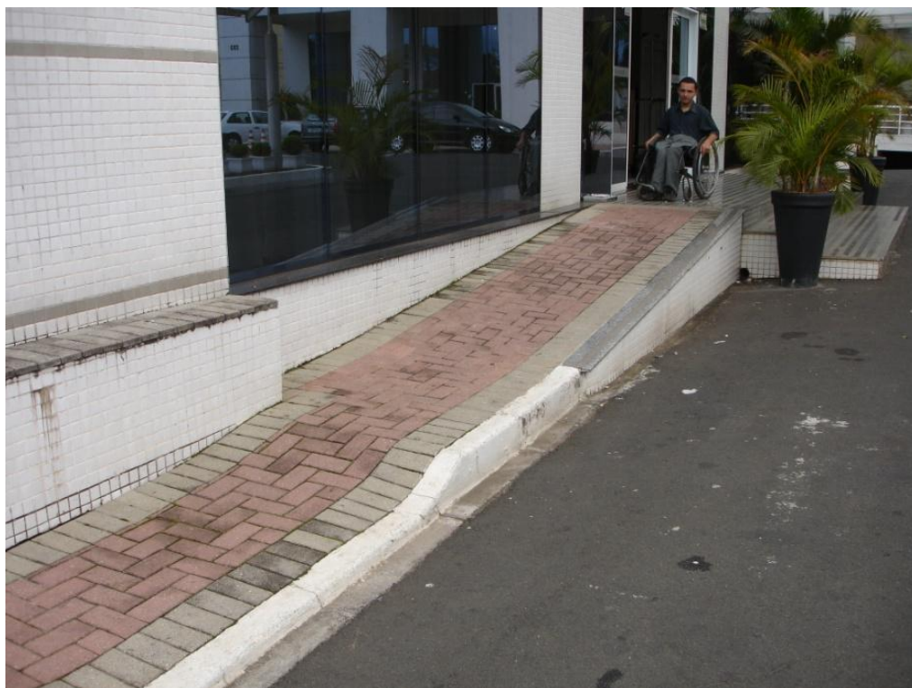
Foto 14 - Rampa de acesso
