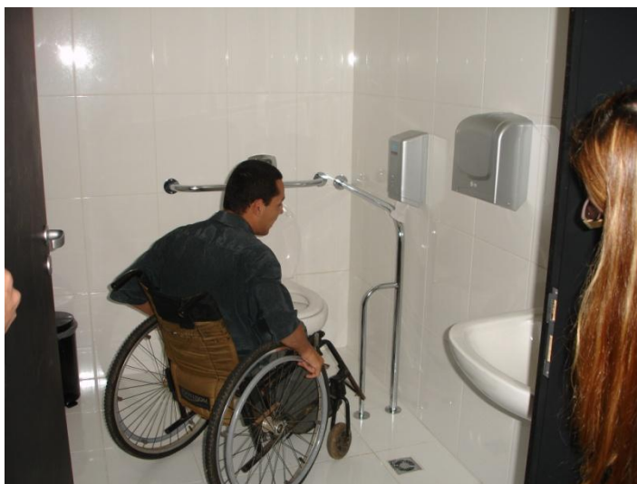
Foto 5 - Banheiro social acessível
