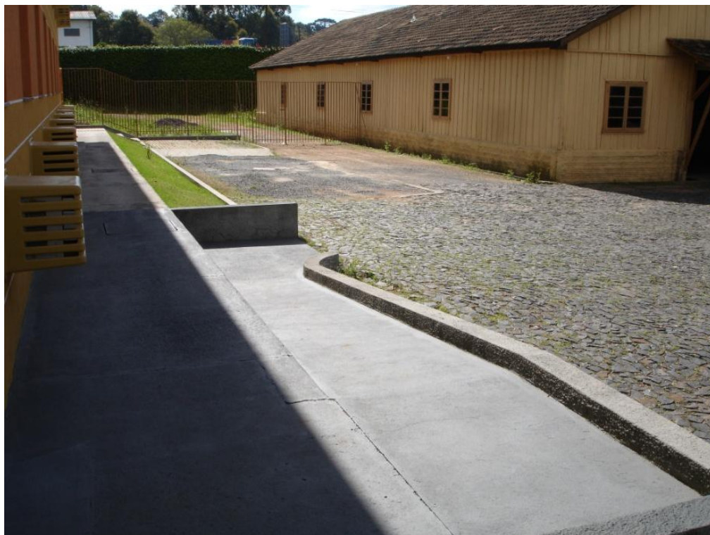
Foto 20 - Rampa de acesso
