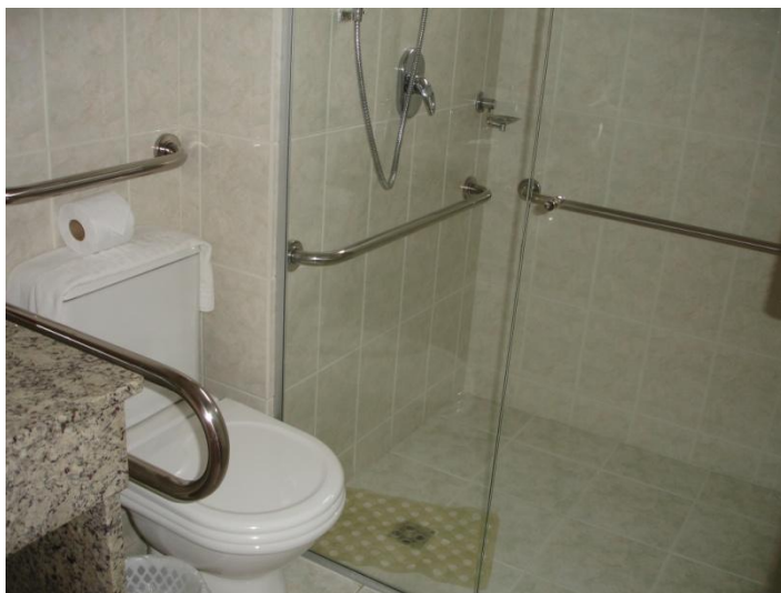
Foto 10 - Banheiro de UH 3
