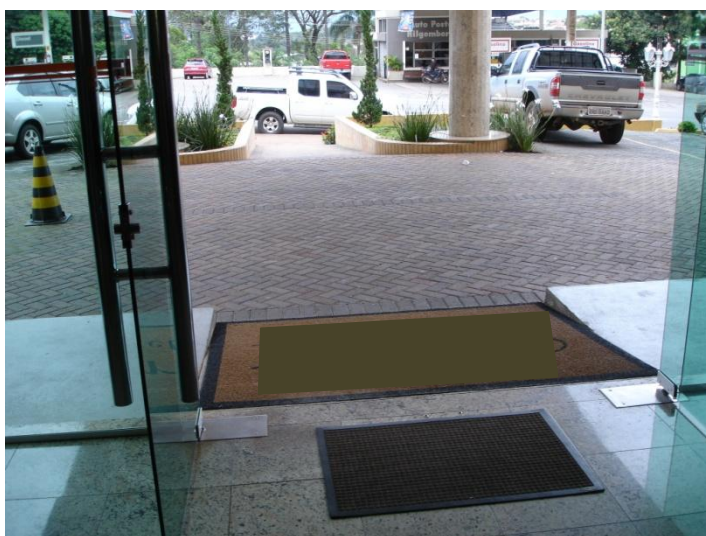
Foto 2 - Porta de entrada com rampa
