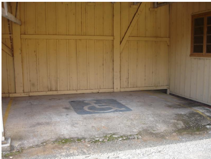
Foto 1 - Vaga de estacionamento sinalizada
