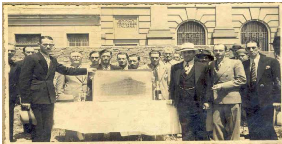
Figura 3 – Lançamento da pedra fundamental do Palace Hotel
