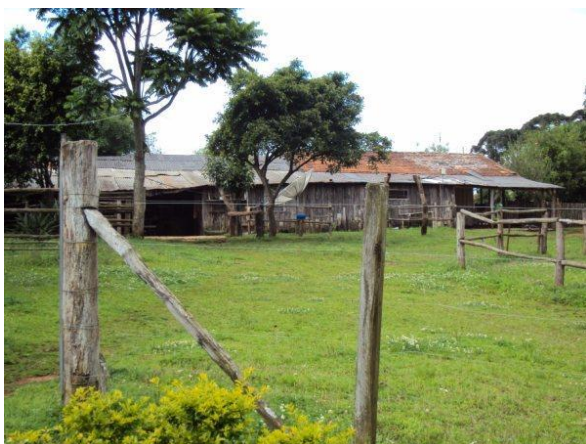
FIGURA 33 - Construção antiga Fonte: Arquivo Pessoal
