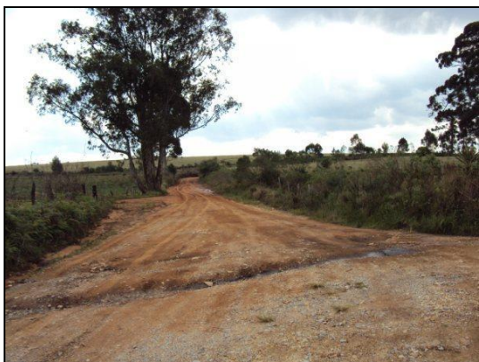
FIGURA 17 – Atual situação da Estrada Sebastião Bastos Fonte: Arquivo Pessoal
