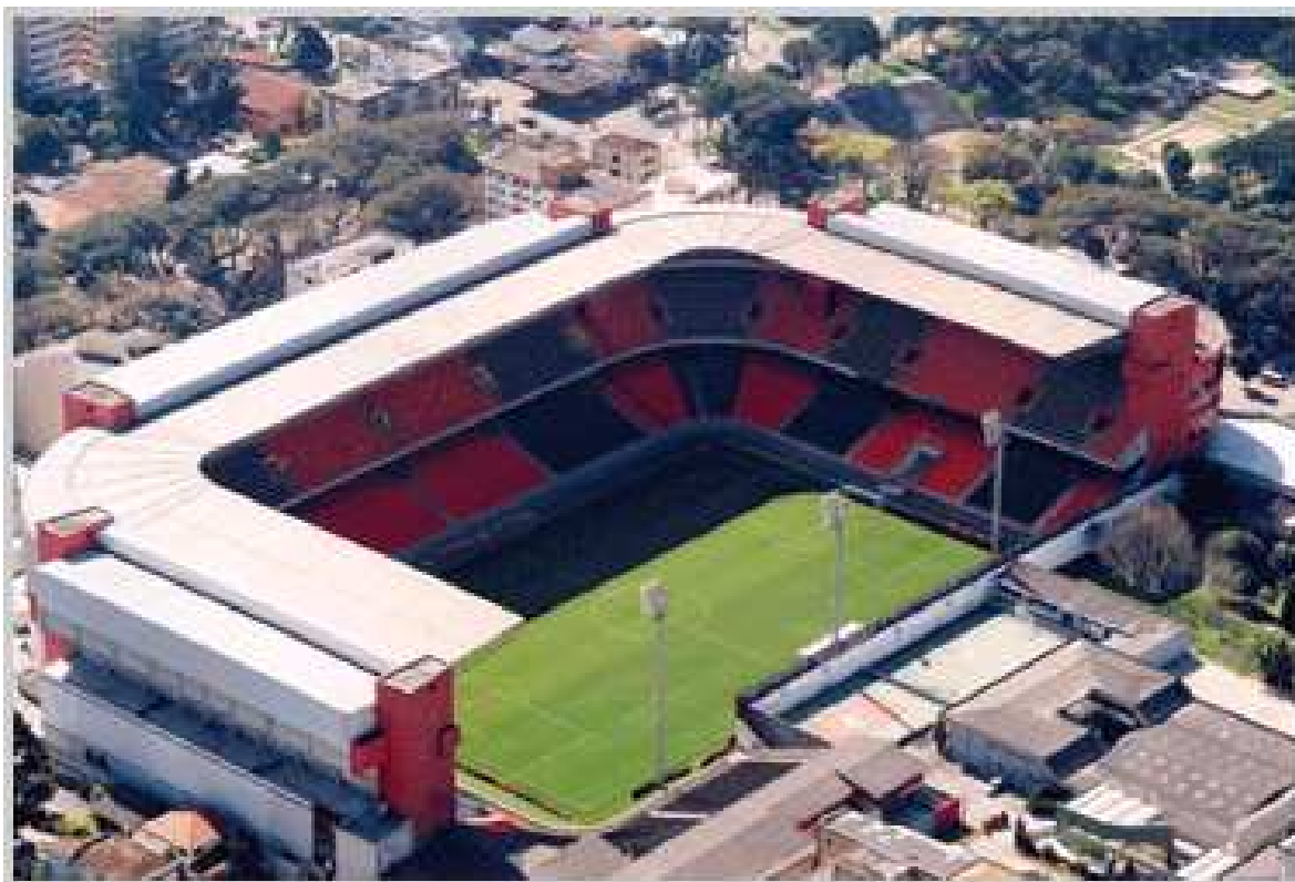
Figura 3 – Imagem aérea da Arena do Clube Atlético Paranaense Fonte: site www.caparanaense.com.br
