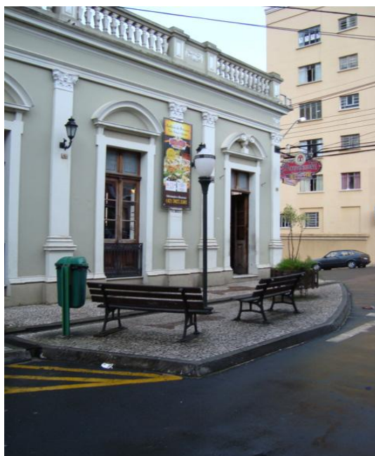
Figura 32: Fachada do Botequim da Antártica Original
