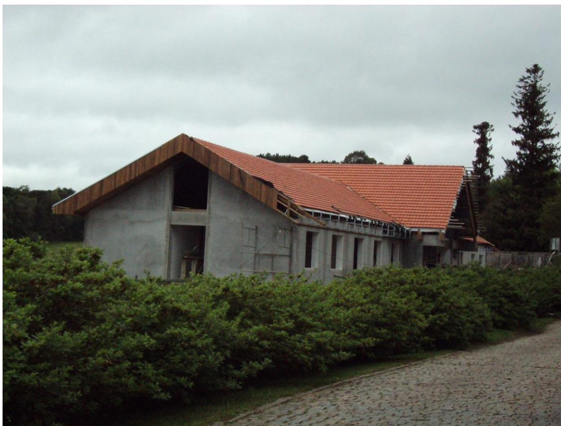
FIGURA 12 – Construção da nova clínica Fonte: O autor (2009)
