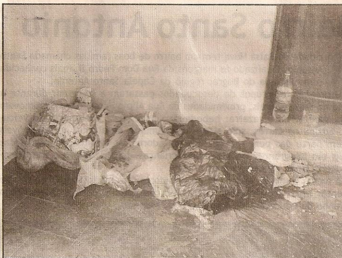
Lixo acumulado demonstra a falta de limpeza no Parque
