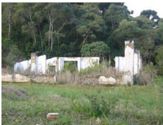
FIGURA 12 – Ruínas de uma antiga edificação – Fonte Plano Diretor do Parque Cambuí 2006
