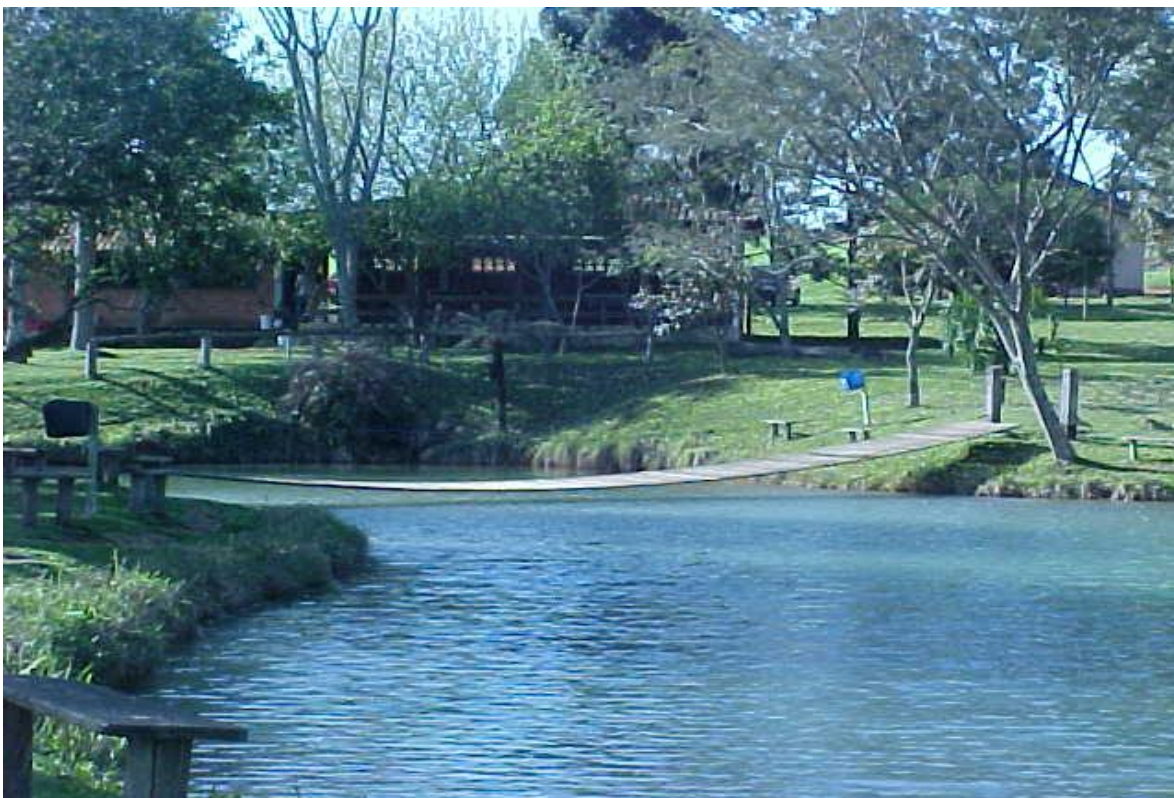
Figura 3 – Ponte pencil Fonte: foto da autora
