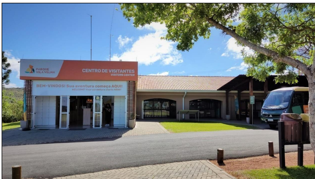
Fotografia 1 - Centro de Visitantes do PEVV.
