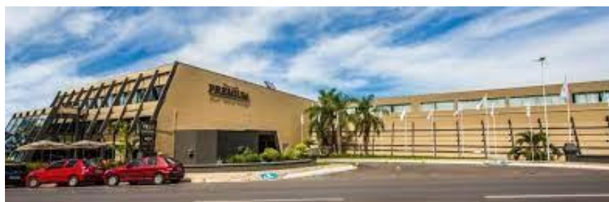
FIGURA 10 - FACHADA PREMIUM HOTEL VILA VELHA
