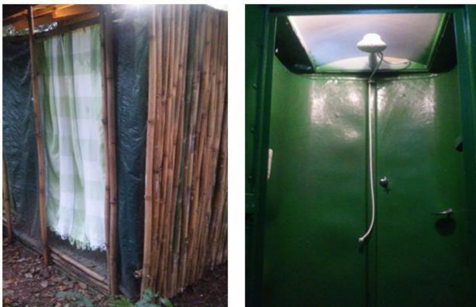
Figura 8 - Cabine de Banho com matérias biorregionais e reutilizados
