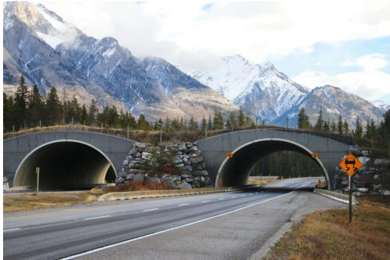
Figura 10 - Estruturas de passagem de fauna no Parque Nacional Banff
