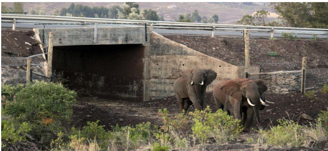
Figura 11 - Túnel subterrâneo para passagens de elefantes no Kenya.
