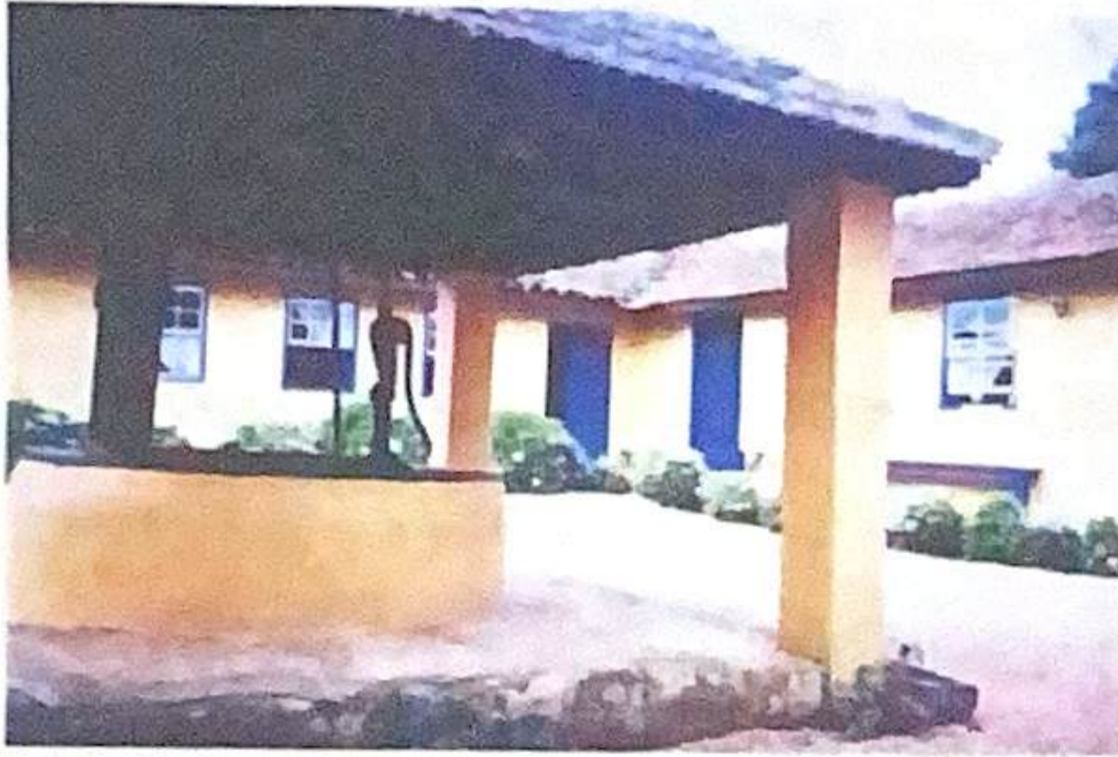
Figura 24- Fundos da casa sede
