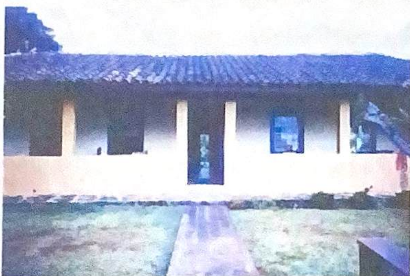
Figura 23- Fachada da Casa Sede
