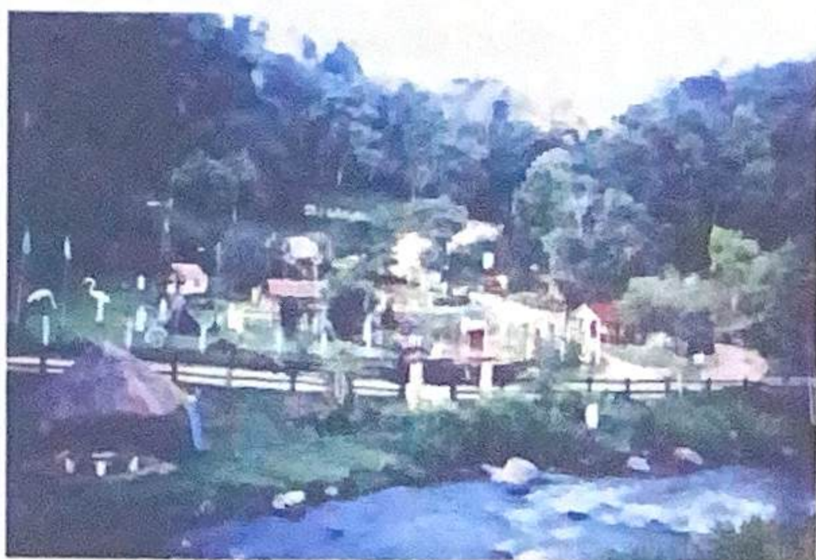
Figura 15- Vista das instalações
