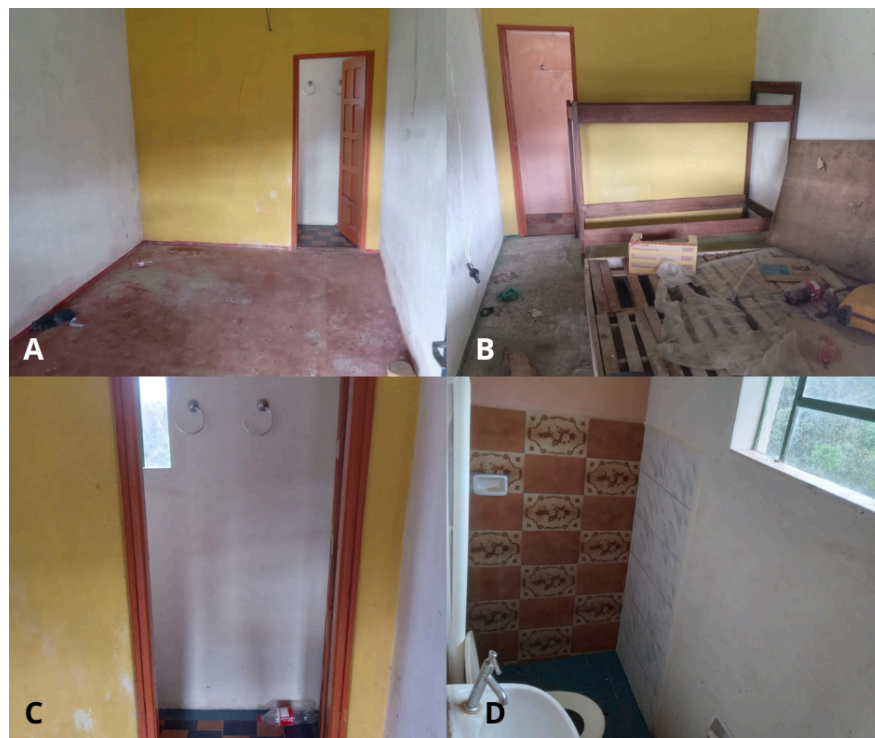
FIGURA 14 - Hospedagem (a)(b): Quartos da hospedagem; (c)(d): banheiros da hospedagem
