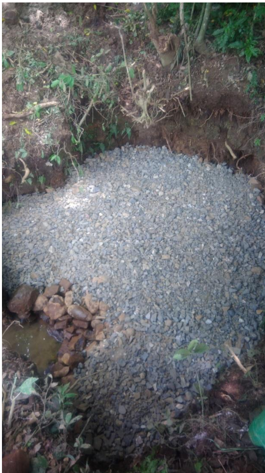
Figura 1: Colocação de pedras no afloramento da água.
