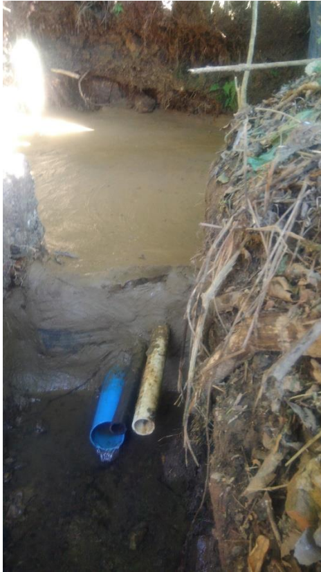
Figura 2: Impermeabilização com a mistura solo cimento.
