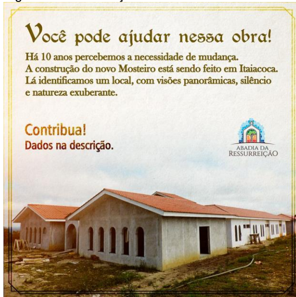
Figura 25 - Construção do novo mosteiro
