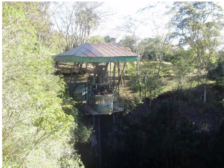
Figura 6 - Elevador da Furna 1
