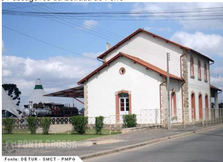
Figura 16: Estação de Passageiros da Estrada de Ferro
