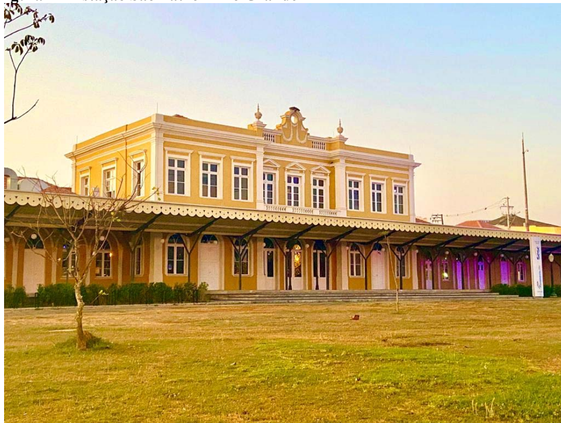
Figura 2 – Estação São Paulo – Rio Grande
