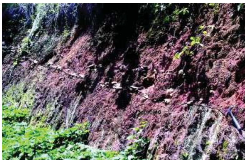
Figura 15 – Perfil típico de saprolito de rocha metamórfica síltico-argilosa (metassiltito e metarritmitos) com cobertura de solo transportado e stone-line (P140).
