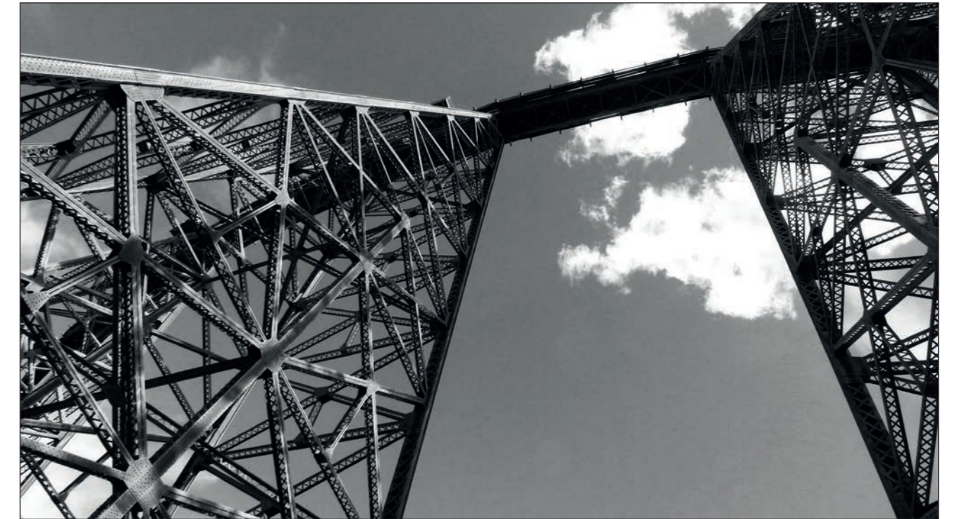
Ponte metálica da ferrovia Salta – Antofagasta conhecida como “La Polvorilla”, por onde passa “el tren de las nubes”, a 4.200 m de altitude. Chorrillos, Salta – 2013.
