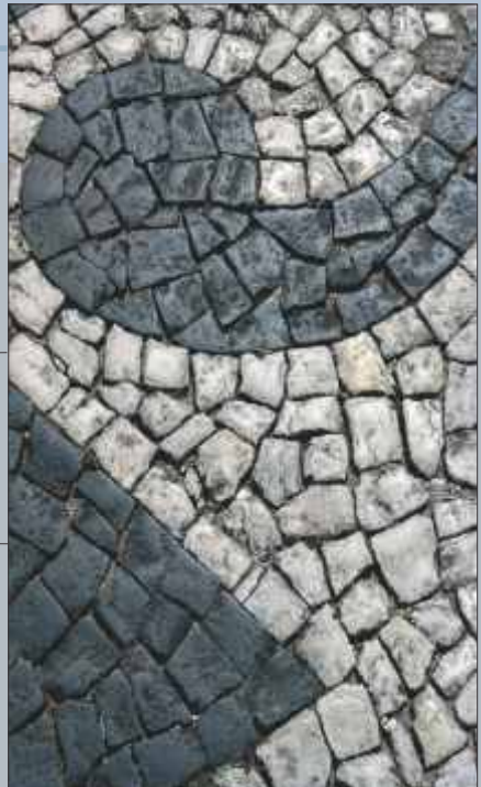
Imagens do mármore dolomítico (claro) e do diabásio (escuro) no pavimento e observadas em microscópio.
