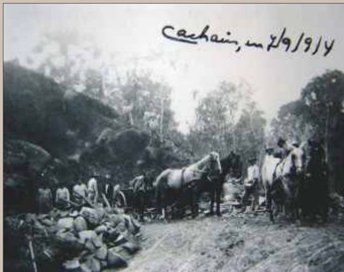
No início do século XX era comum a extração de blocos de diabásio para a pavimentação da cidade com paralelepípedos e lousinhas. As lavras eram pequenas e a técnica de beneficiamento totalmente manual. Acima imagem deste tipo de mineração no bairro Cachoeira, ao norte da cidade, em 1914. Acervo Casa da Memória de Curitiba.
