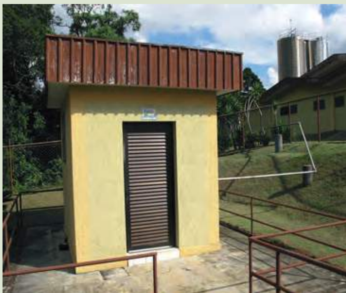
Fonte - poço tubular da água mineral Frescale
