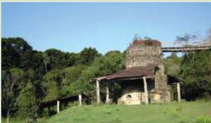
Forno de Cal situado próximo a Igreja do Marmeleiro.
