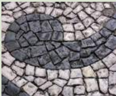
Calçada de petit pavê feita com bloquinhos de diabásio (rocha escura) e metadolomito (rocha clara)
