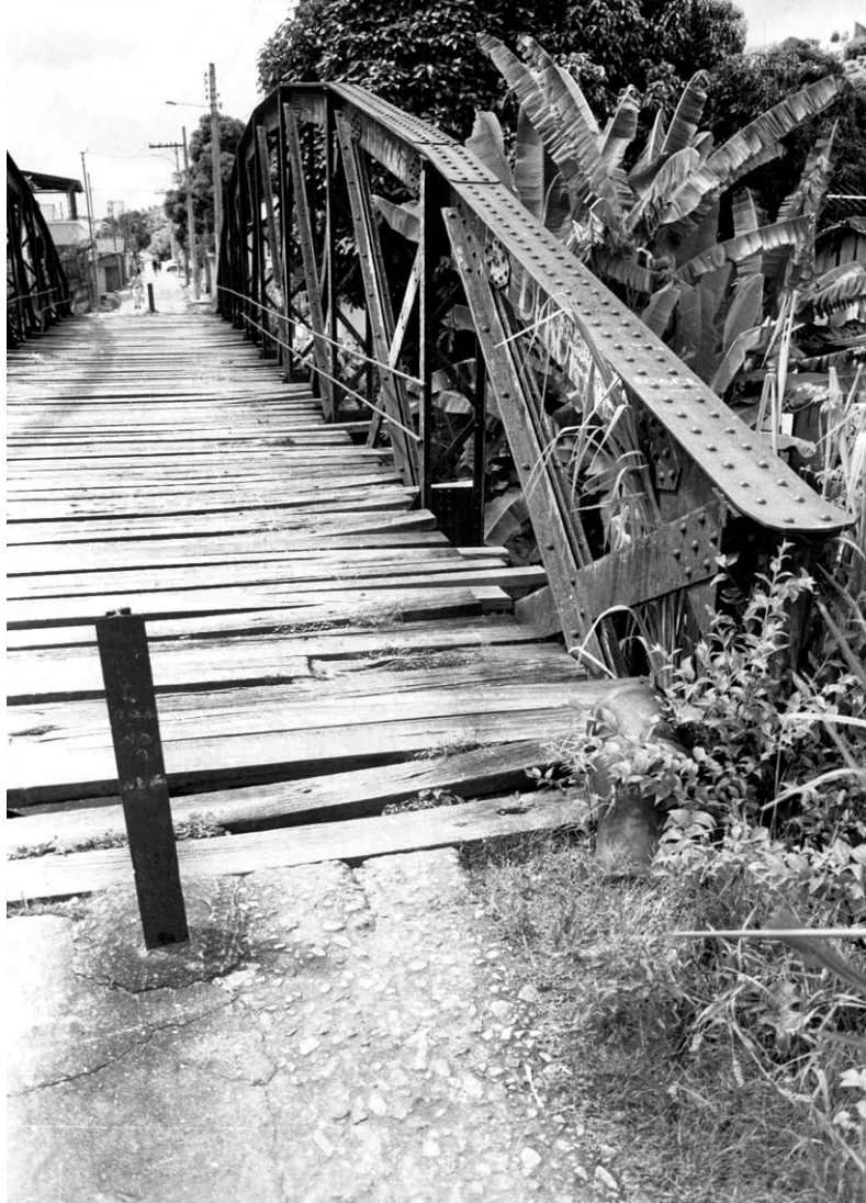
Pontilhão em estrutura metálica sobre o Rio Todos os Santos (atual rua Júlio Costa) na cidade de Teófilo Otoni. Tombado pela Prefeitura Municipal no ano de 2010.
