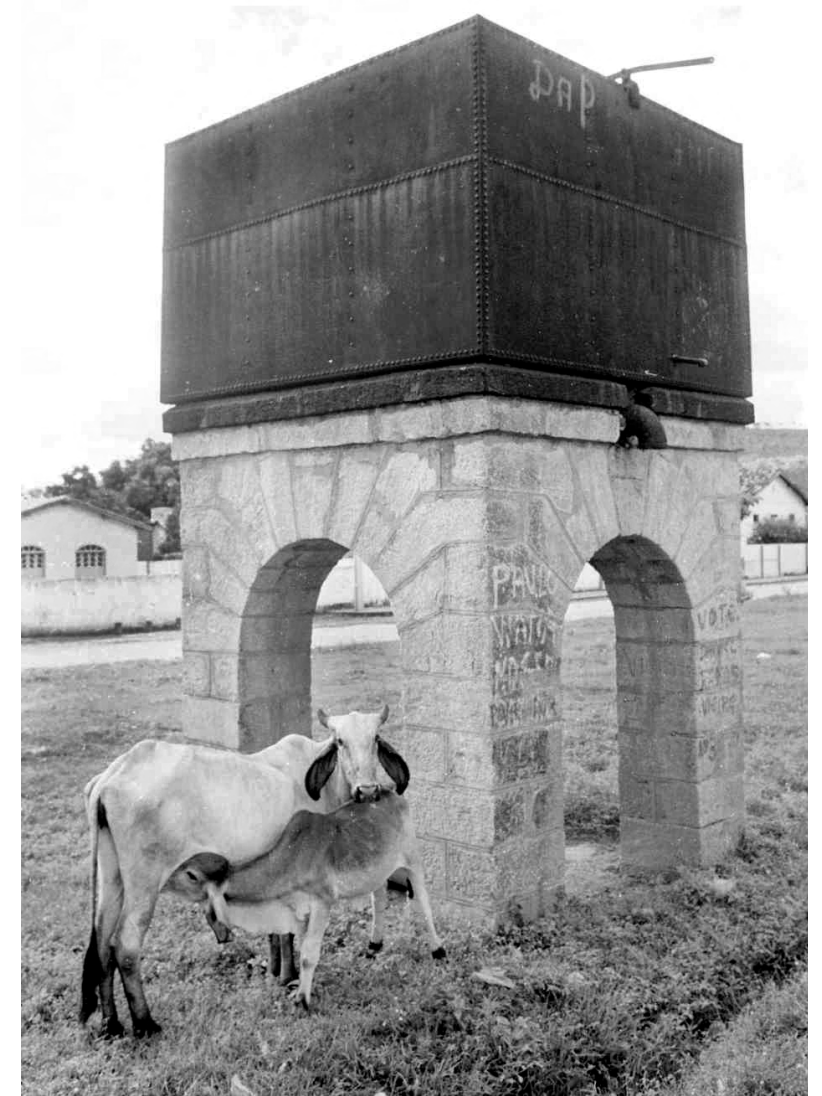
Caixa d'água sobre cantaria de granito. Queixada.
