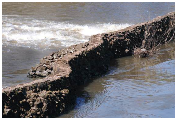
Na década de 1980 a Mineropar (Serviço Geológico do Paraná) construiu um muro de contenção das águas do rio Tibagi, em Telêmaco Borba, com a finalidade de mineração de diamante. Esta foi uma obra de proporções épicas dadas as dificuldades de enchentes no rio. Recentemente, com a construção da usina hidrelétrica de Mauá, os vestígios desta obra foram cobertos pelo lago artificial. Este era um raro exemplo de arqueologia da mineração no sul do Brasil.
