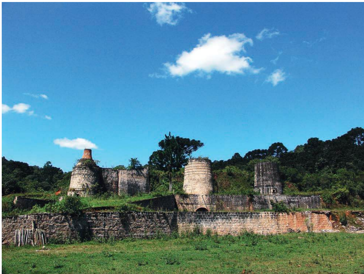
Fornos de cal são uma presença constante nas regiões de Socavão e Itaiacoca (leste de Castro e de Ponta Grossa). A extração de rochas carbonáticas (metacalcários, mármore e metadolomitos) do Embasamento e seu processamento por moagem e queima ocorre nestas regiões desde as primeiras décadas do século XX e representam importante fator econômico para estes municípios.
