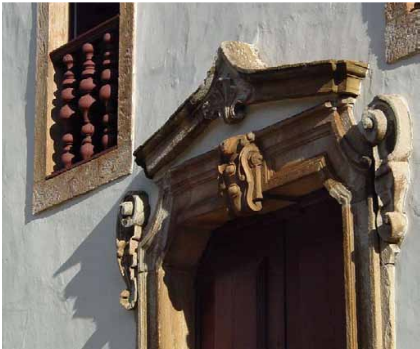
Capela Padre Faria - Diferentes colorações do quartzito na portada indicam eventuais restaurações
