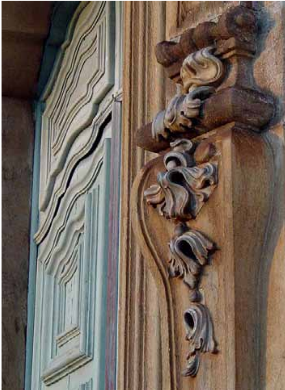
Porta da Capela do Carmo - marcante interação do quartzito com a pedra-sabão por encaixes ocultos
