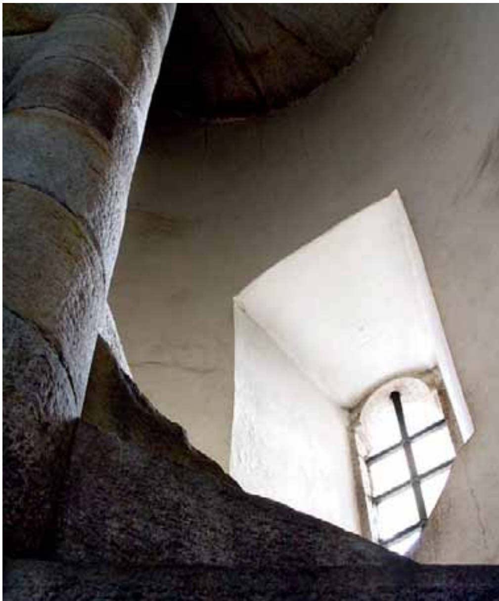
Escadaria de acesso ao sino na torre da Capela do Carmo
