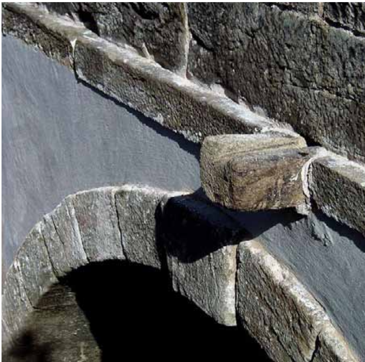
Buzinote e detalhes da Ponte de Marília, restaurada pelo mestre Juca em 2001
