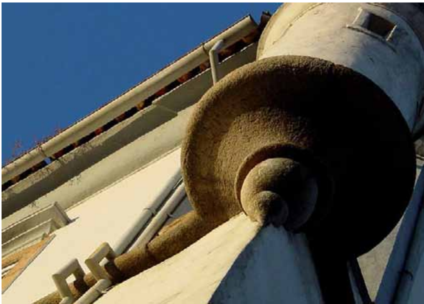
Detalhe da guarita do Antigo Palácio dos Governadores
