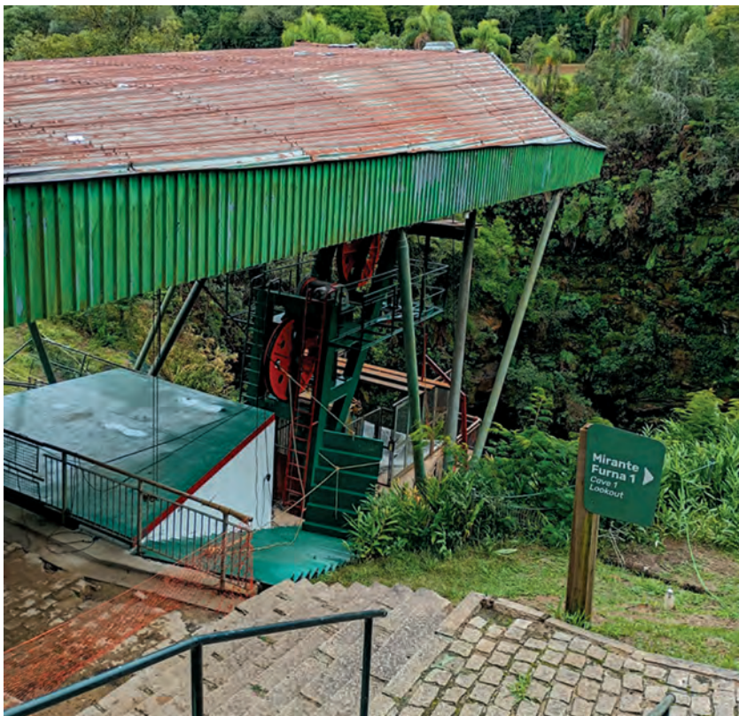
Obras para retomar atividades do atrativo do Elevador de Furna em Vila Velha
